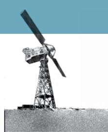
En 1941, la puissance de l'éolienne de Putnam (1,25 MW) prouvait l'avantage de matériaux plus légers.
